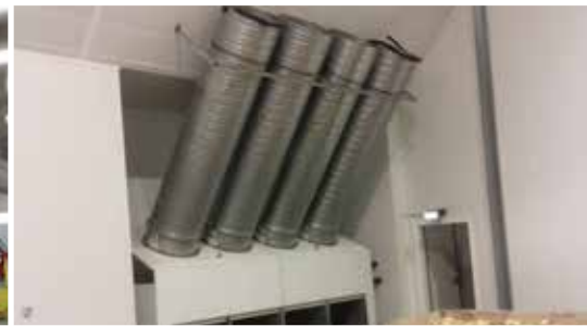
Évaporateur dans une chambre de stockage
