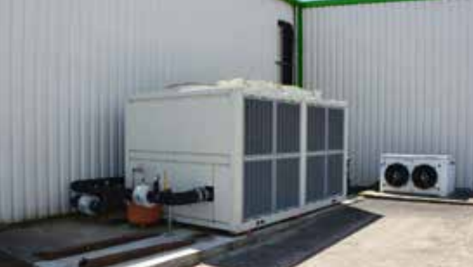
Production frigorifique monobloc au CO 2 et distribution à l'eau glycolée
