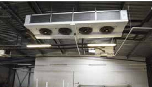
Frigorifère dans un hall de stockage
