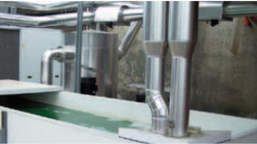
Bac de décantation d'une ligne de refroidissement
