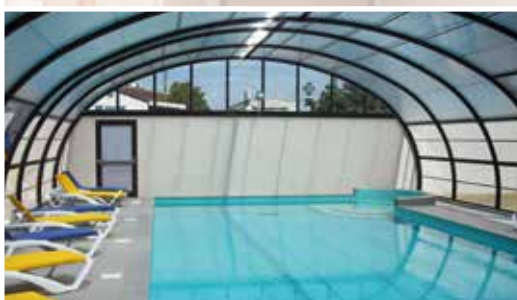
Chauffage de piscine par énergie solaire
