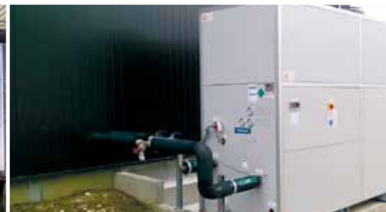
Production monobloc chaud et froid prêt-à-brancher
