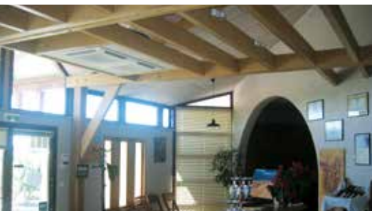
Chauffage et rafraîchissement en zone d'accueil
