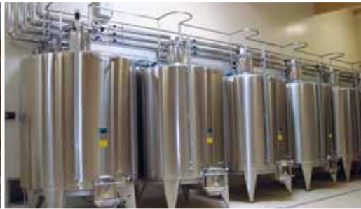
Installation de réseau inox isolé pour cuverie
