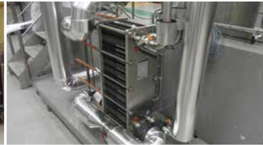
Process de filtration à froid
