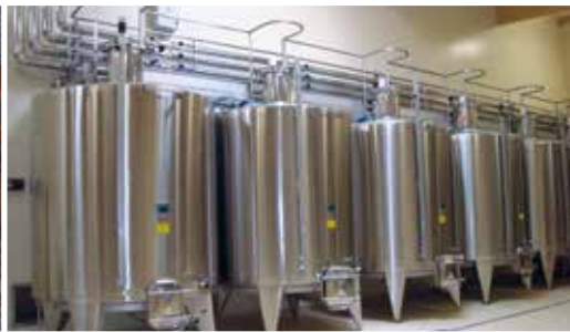
Installation de réseau inox isolé pour cuverie
